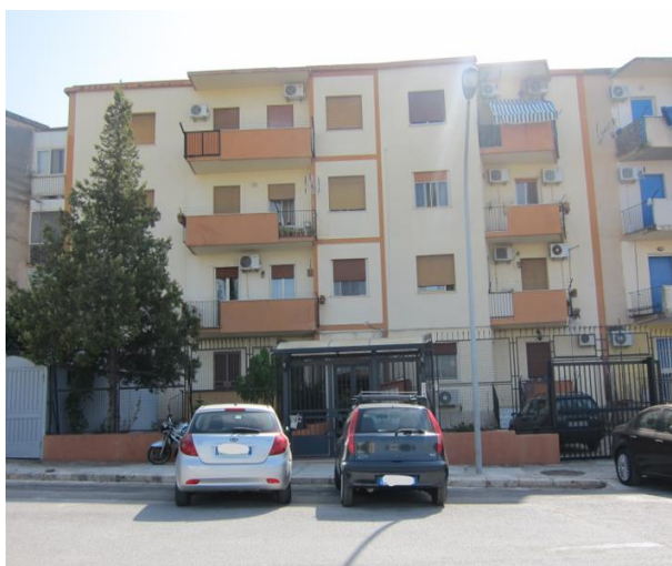
Prospetto su Largo Pozzillo
