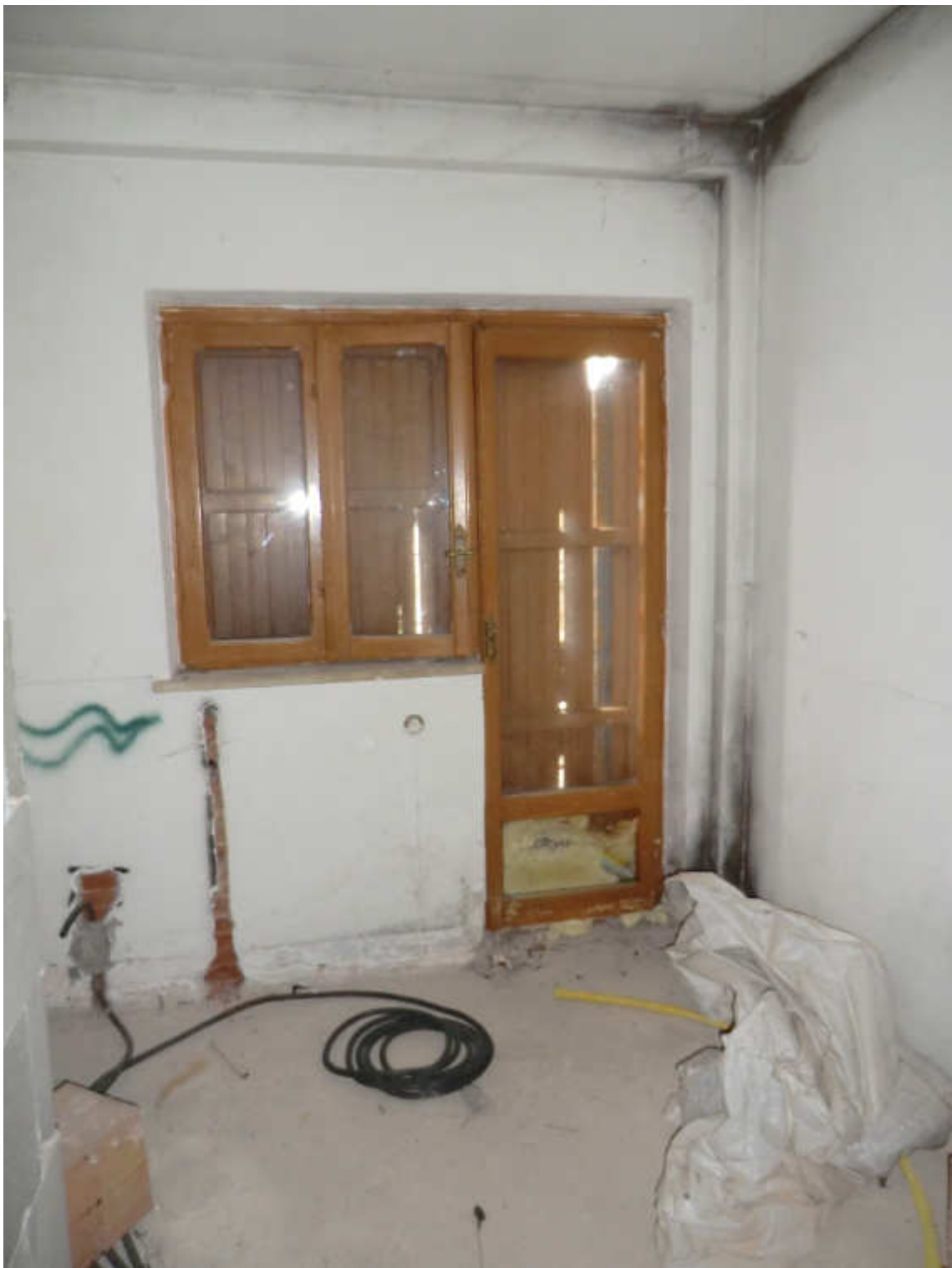
Foto n. 17 - Particolare degli infissi esterni
