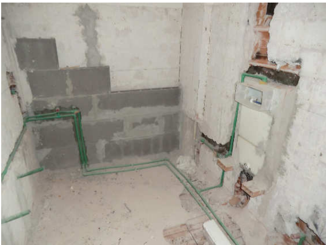
Foto n. 10 - Bagno in fase di ristrutturazione
