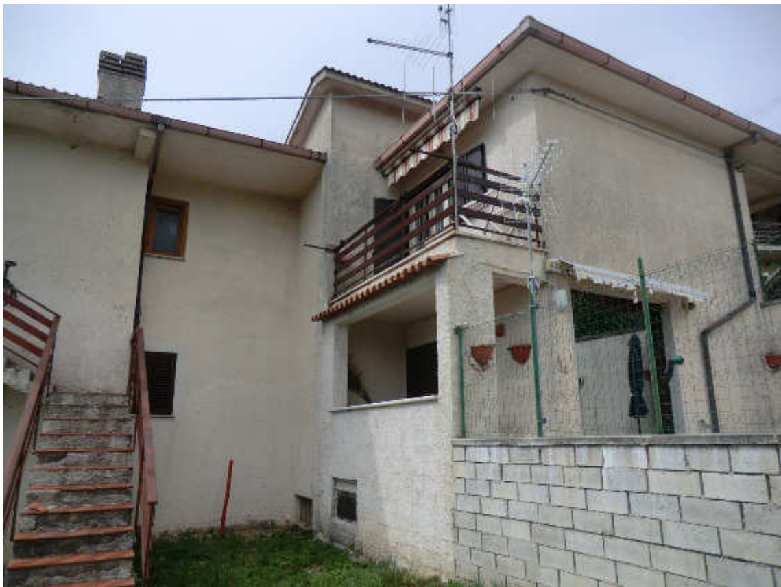
Foto n. 5 - Altra vista posteriore del fabbricato
