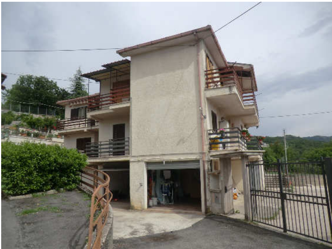
Foto n. 1 - Vista generale del fabbricato dalla strada di accesso
