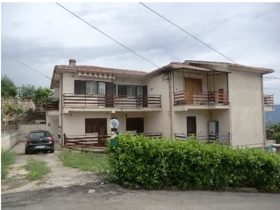
Foto n. 2 - Altra vista del fabbricato dalla strada
