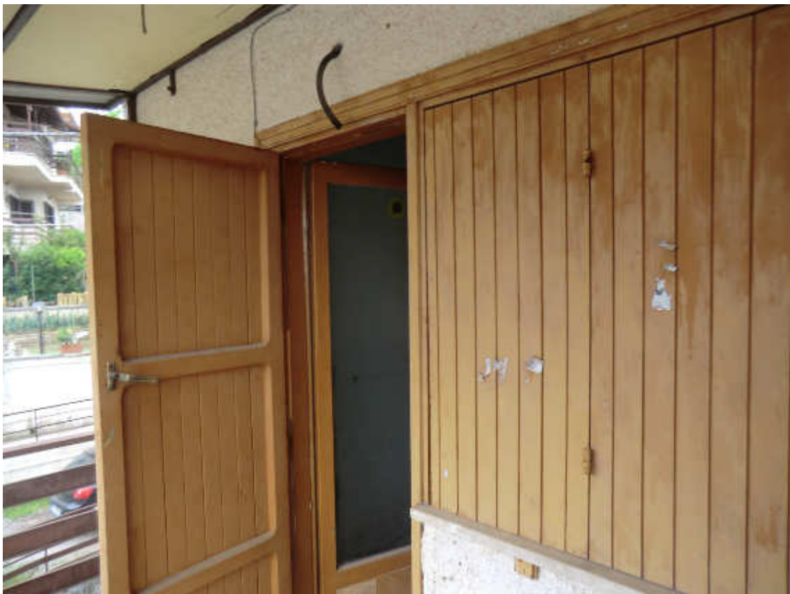
Foto n. 7 - Ingresso dell'appartamento visto dall'esterno
