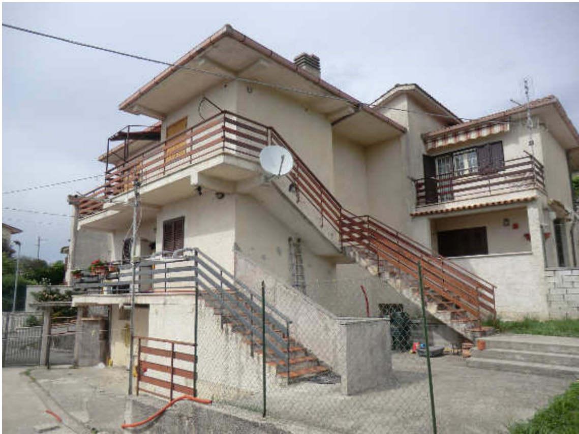
Foto n. 3 - Vista laterale del fabbricato
