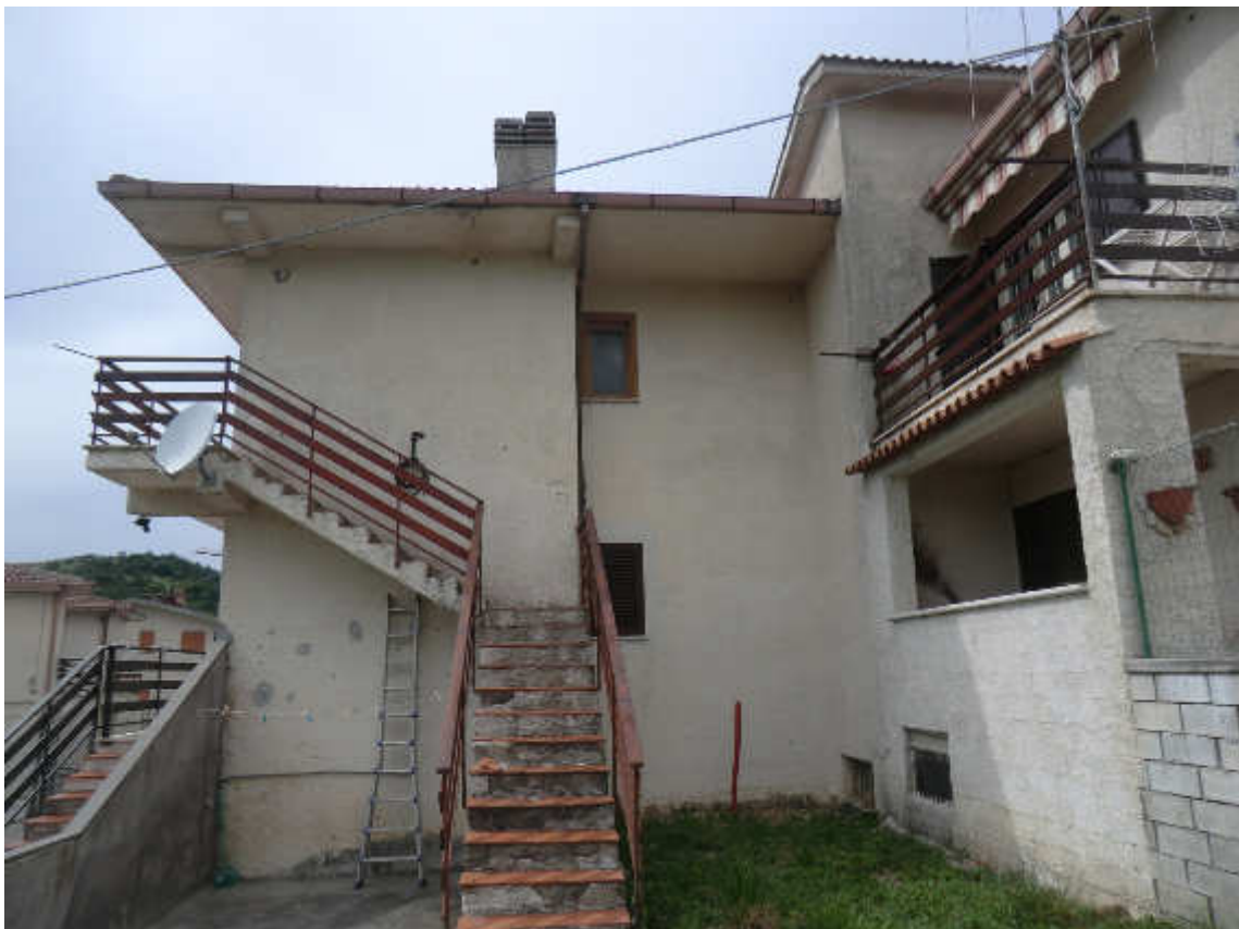
Foto n. 4 - Vista posteriore del fabbricato
