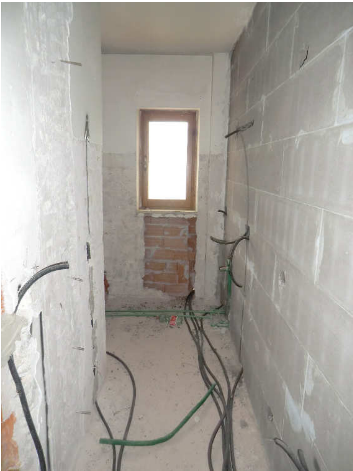
Foto n. 11 - Ingresso del bagno in fase di ristrutturazione
