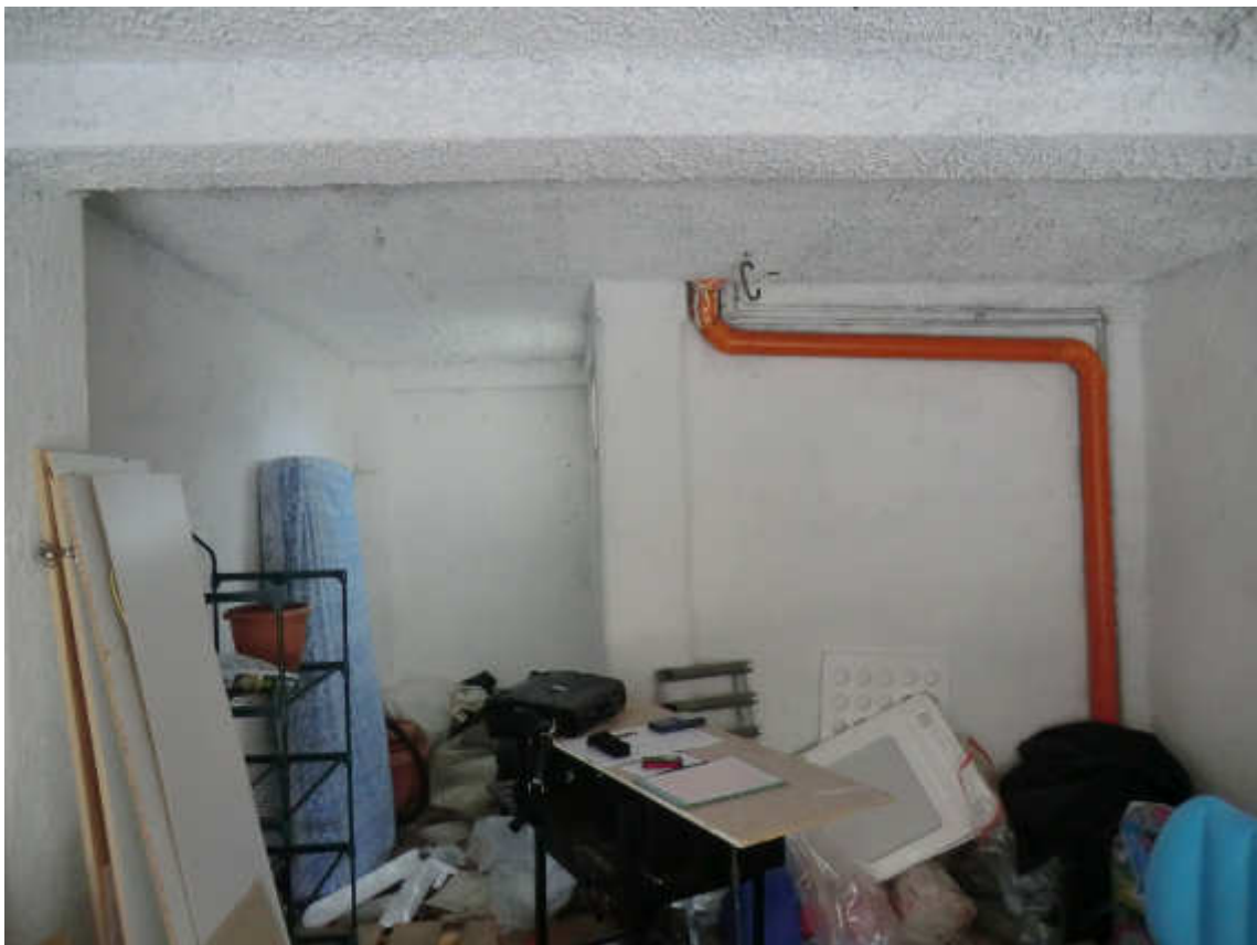
Foto n. 20 - Particolare interno del garage
