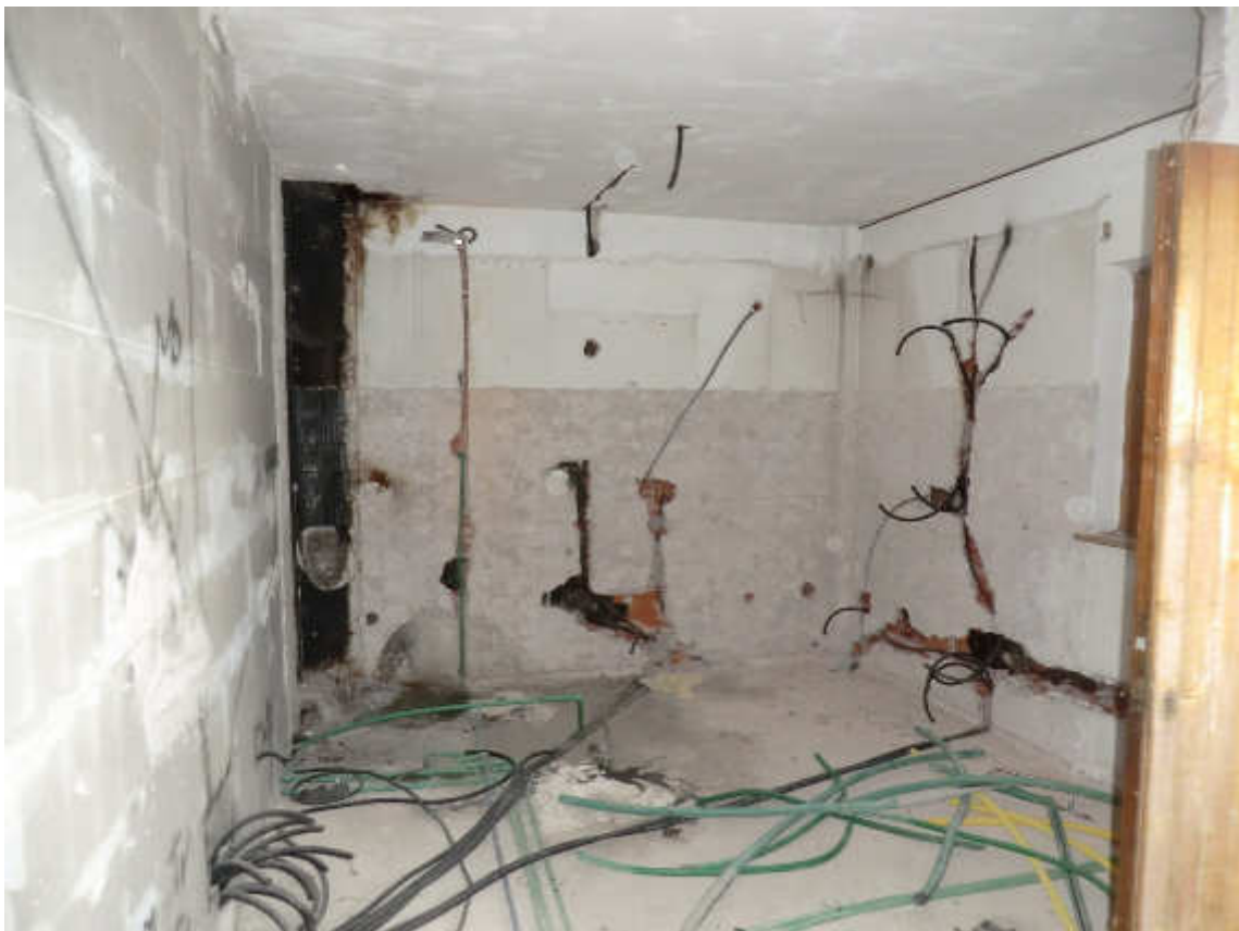
Foto n. 9 - Zona pranzo cucina in fase di ristrutturazione
