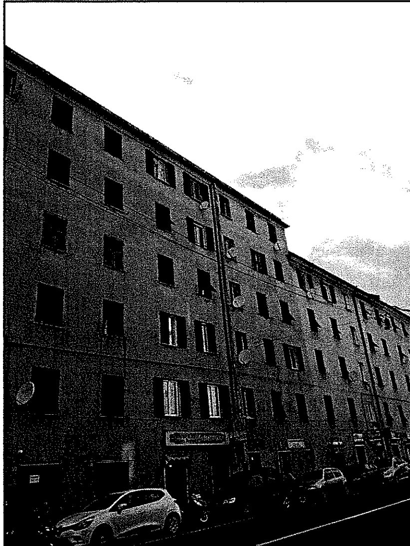
FOTO N. 1 – Contesto – Facciata su via Rivarolo
