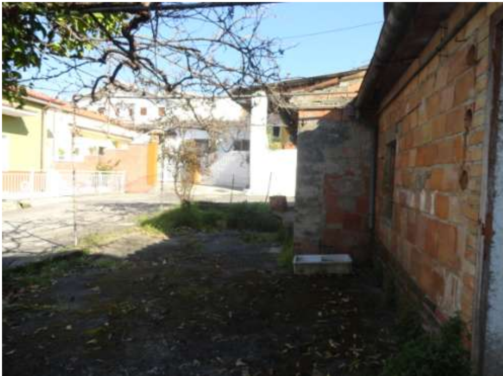
POSA N° 12 – FOTO CON PUNTO DI VISTA ALL'ESTERNO DELL'IMMOBILE - ZONA – INTERNA AL GIARDINETTO - VISTA VERSO VIA TELESIO
