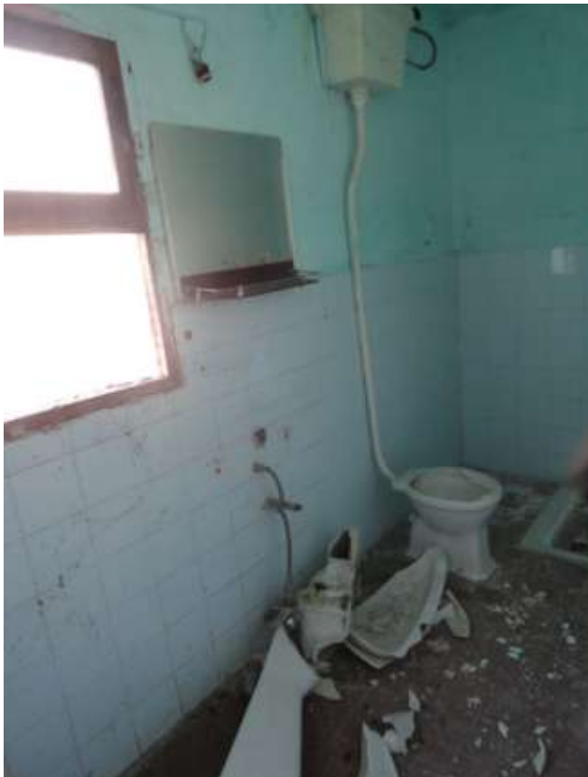
POSA N° 6 – FOTO CON PUNTO DI VISTA ALL'INTERNO DELL'IMMOBILE – ZONA SERVIZIO (WC)
