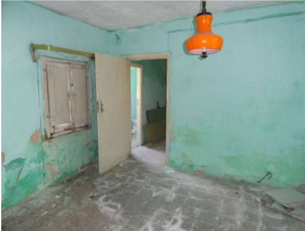
POSA N° 5 – FOTO CON PUNTO DI VISTA ALL'INTERNO DELL'IMMOBILE - ZONA STANZA ATTIGUA AL GIARDINETTO
