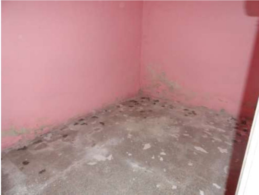
POSA N° 9 – FOTO CON PUNTO DI VISTA ALL’INTERNO DELL’IMMOBILE - ZONA - STANZA PROSPICIENTE IL PATIO – PARTICOLARE PAVIMENTO
