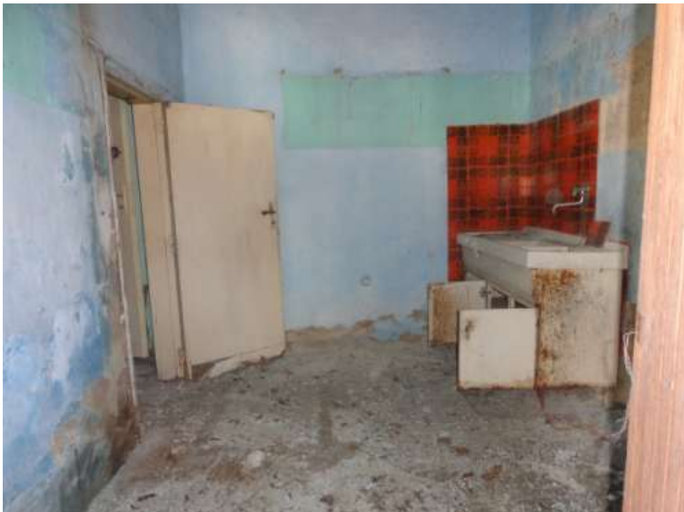
POSA N° 4 – FOTO CON PUNTO DI VISTA ALL’INTERNO DELL’IMMOBILE – ZONA LAVELLO - CUCINA
