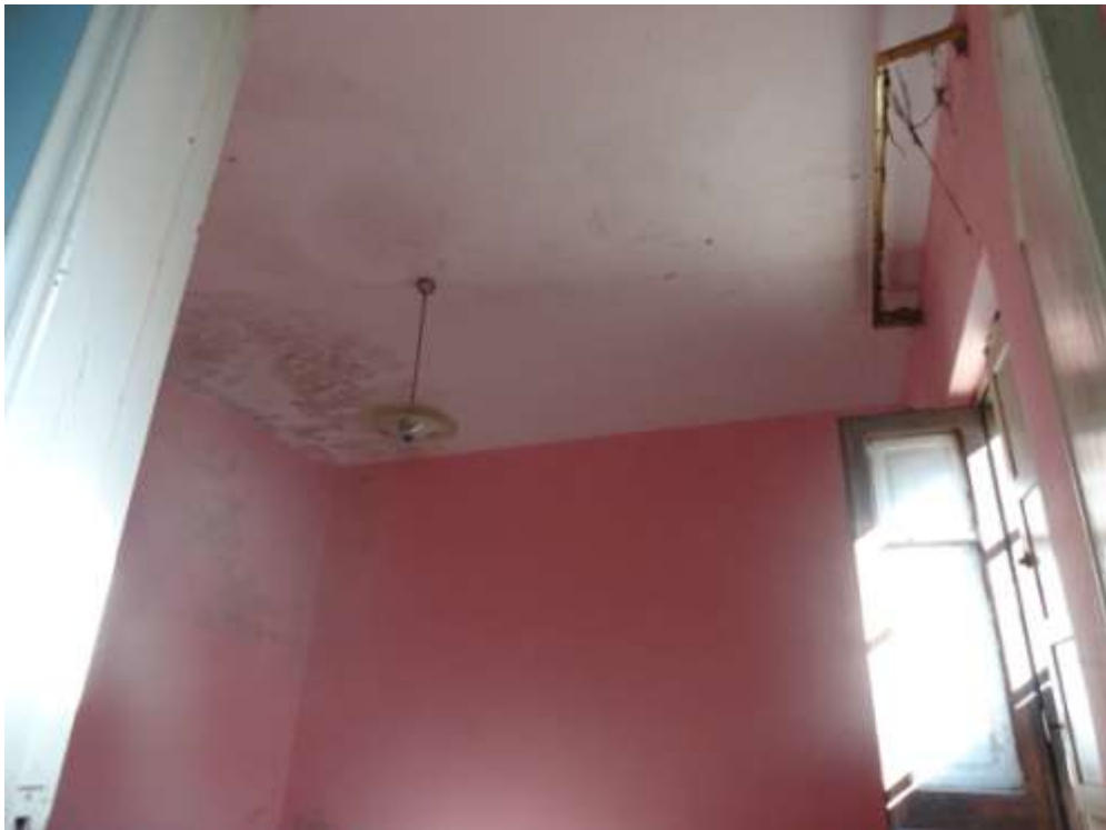
POSA N° 8 – FOTO CON PUNTO DI VISTA ALL'INTERNO DELL'IMMOBILE – ZONA - STANZA PROSPICIENTE IL PATIO
