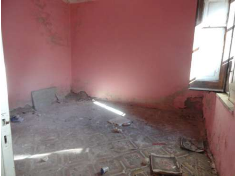
POSA N° 7 – FOTO CON PUNTO DI VISTA ALL'INTERNO DELL'IMMOBILE - ZONA - STANZA PROSPICIENTE IL PATIO
